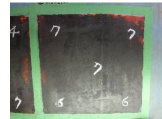
塗膜はく離除去作業完了状態 残存膜厚: 7μm (平均)
