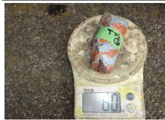
はく離回収した塗膜重量測定状態 60g/0.090m 2 ≒ 667g/m 2
