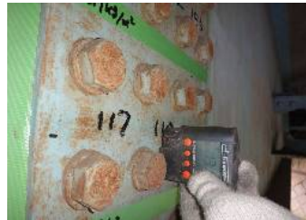
既存塗膜の膜厚測定 使用機器: 電磁式デジタル膜厚計
