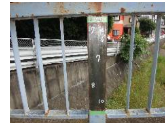
塗膜はく離除去作業完了状態 残存膜厚: 8μm (平均)
