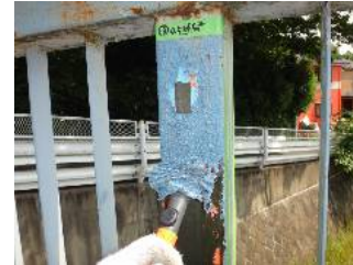
塗膜はく離作業 (1回目) 使用工具: 刃付スクレーパー
