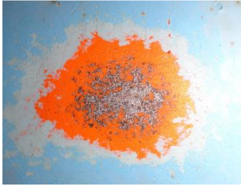
鋳桁 腹板部 既存塗膜構成
