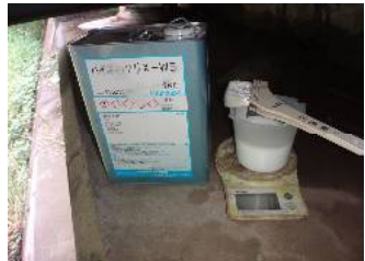
バイオハクリX-WB (鋼構造物用 水系塗膜はく離剤) 塗付方法: 刷毛塗り 塗付量確認方法: 重量管理法 試験区画面積: 0.050m 2 試験区画への塗付量: 0.5 kg/m 2 試験区画への塗付量: 0.5 kg/m 2 (≒ 25g/0.050m 2 )
