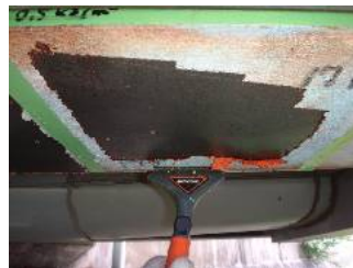
塗膜はく離作業 (1回目) 使用工具: 刃付スクレーパー
