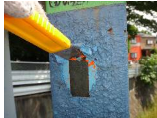
塗膜の軟化状態の確認 皮スキなどで塗膜の軟化状態を確認する。
