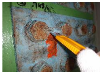
塗膜の軟化状態の確認 皮スキなどで塗膜の軟化状態を確認する。
