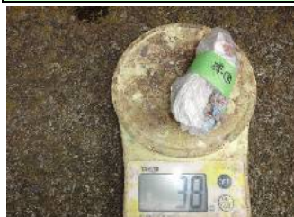
はく離回収した塗膜重量測定状態 38g/0.048m 2 ≒ 792g/m 2
