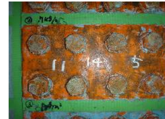
塗膜はく離除去作業完了状態 残存膜厚: 10μm (平均)
