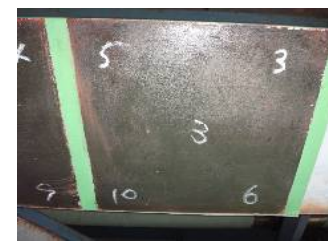
塗膜はく離除去作業完了状態 残存膜厚: 5μm (平均)
