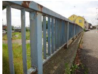
試験部位: 高欄部 左から No.4-③ 高欄部 既存塗膜厚: 229 μm
