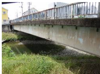
橋梁名: ○○○橋 外景
