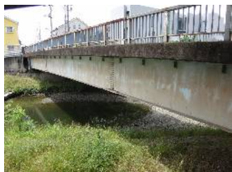
橋梁名: ○○○橋 外景
